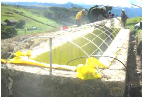
Biodigester en zanja, para estabilizar la temperatura, en sierra
