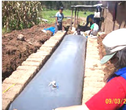
Biodigester tubular de 10 m 3 , para cuyes
